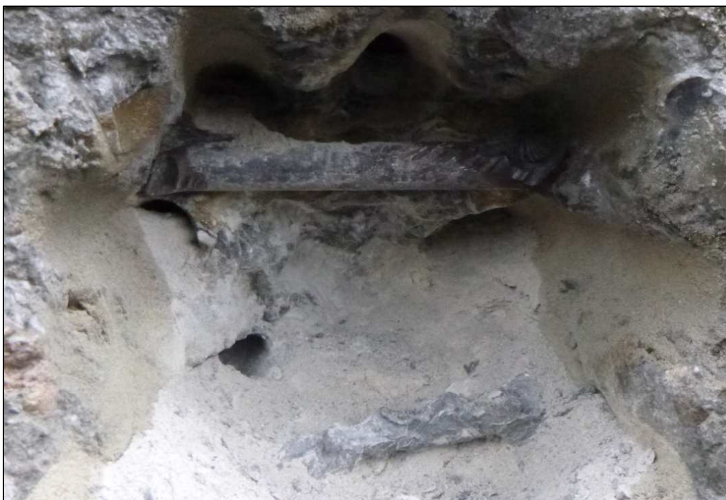
Obrázek 22 – sonda S2 – vodorovná výztuž \varnothing 12 mm, bez korozního úbytku, krytí 55 mm
