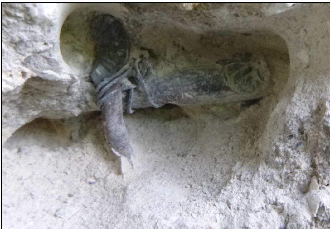
Obrázek 23 – sonda S3 – vodorovná výztuž \varnothing 12 mm, svislá výztuž 6 mm, obě bez korozního úbytku, krytí 45 mm
