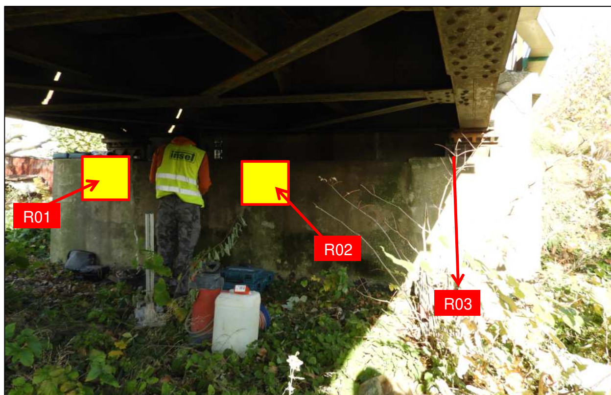
Obrázek 9 – pohled na opěru 1 s vyznačením rozmístění radarových snímků
