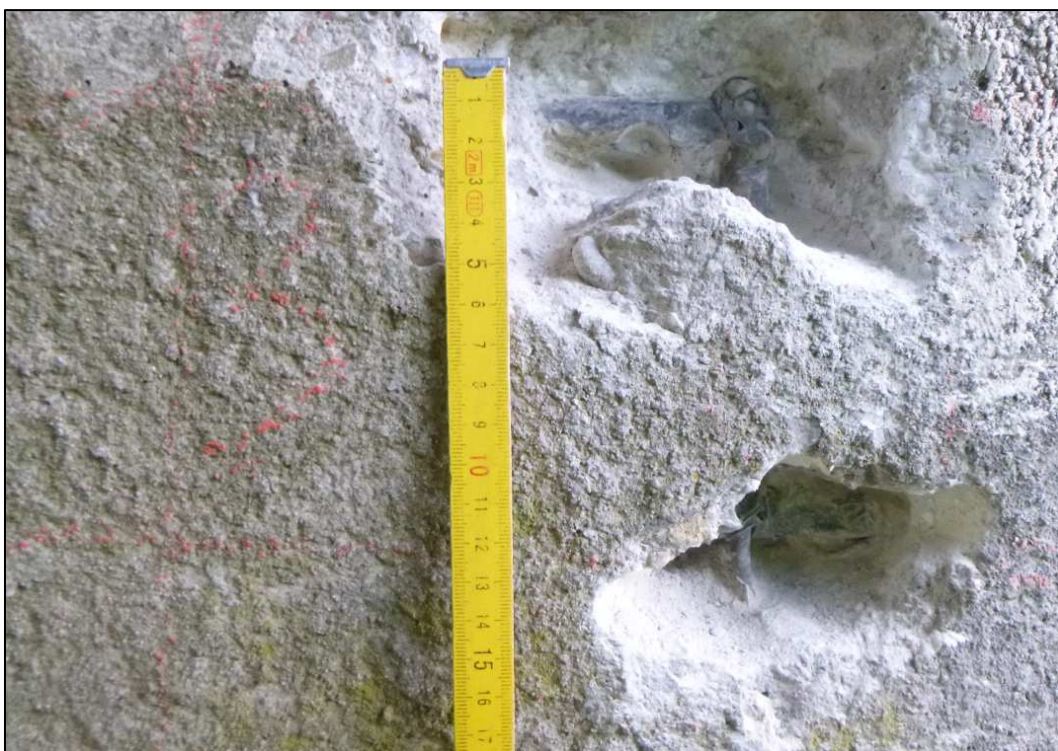
Obrázek 24 – sonda S3 – vodorovná výztuž \varnothing 12 mm, svislá výztuž 6 mm, obě bez korozního úbytku, krytí 45 mm
