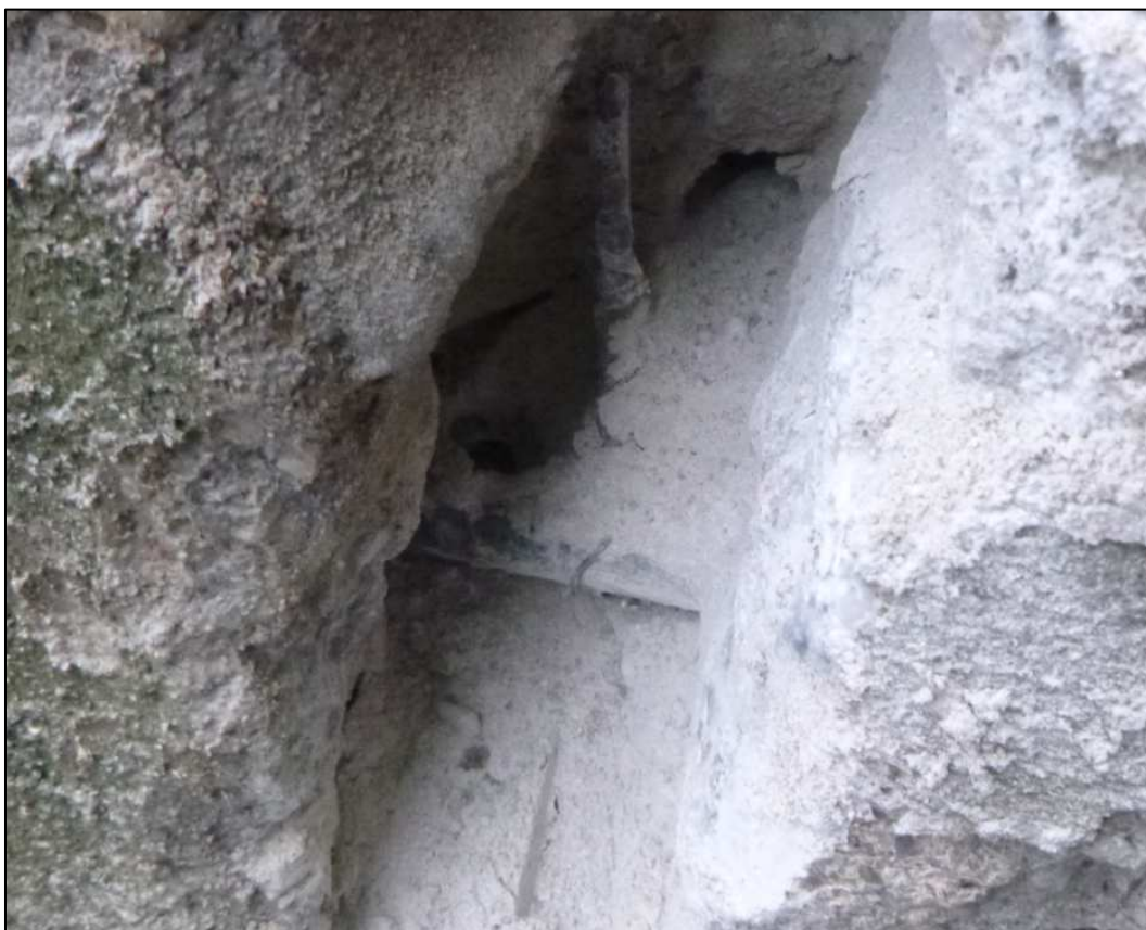
Obrázek 21 – sonda S1 – vodorovná výztuž \varnothing 12 mm, svislá výztuž 6 mm, obě bez korozního úbytku, krytí 55 mm
