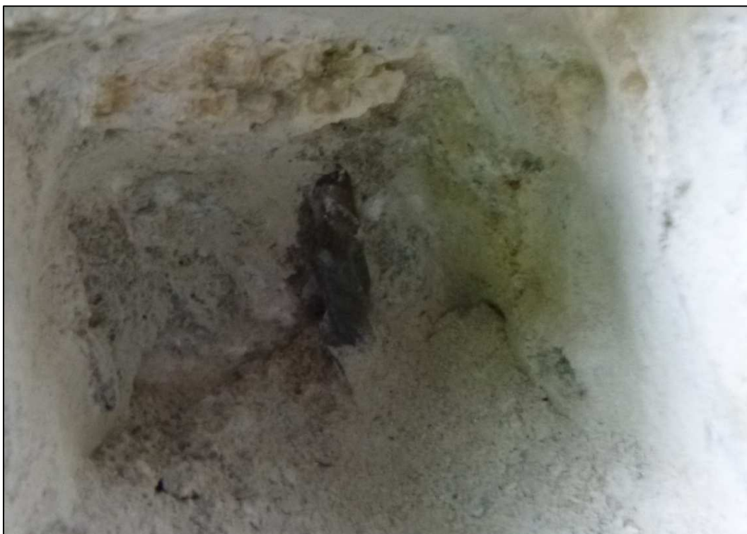
Obrázek 25 – sonda S4 – svislá výztuž \varnothing 6 mm, bez korozního úbytku, krytí 85 mm
